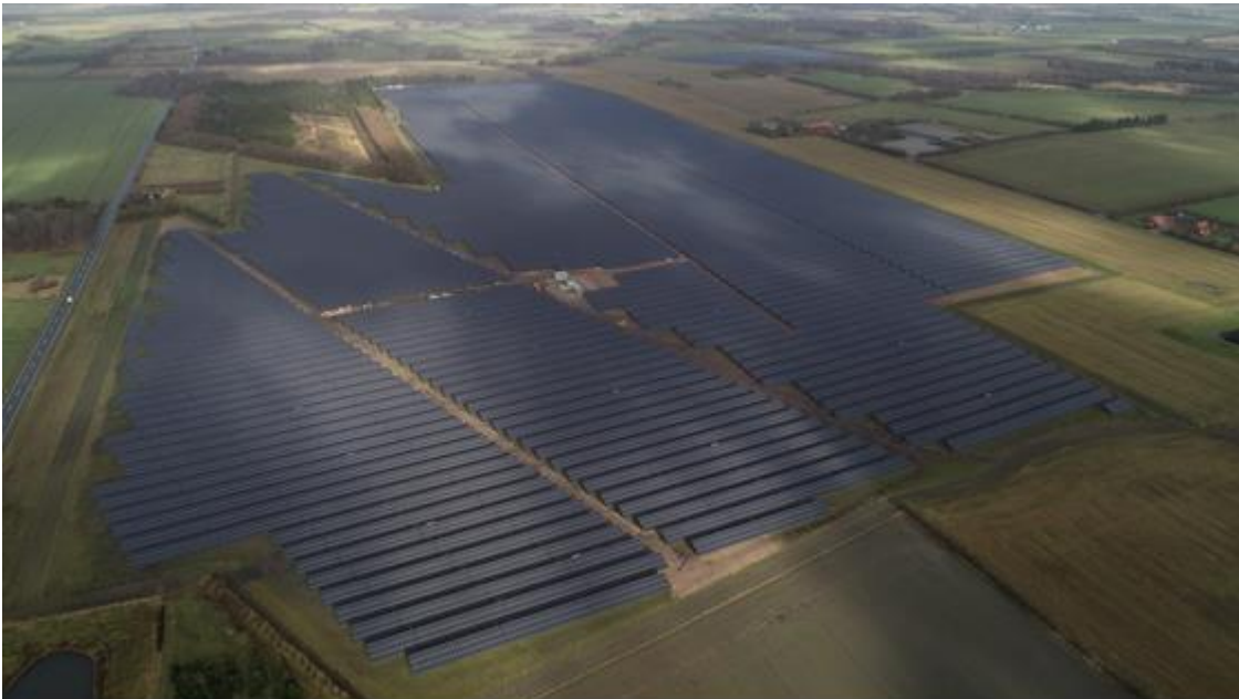
Kuva 6-2. Esimerkkikuva toteutuneesta aurinkovoimalasta. Kuvasta poiketen tyypillinen suomalainen aurinkovoimala sijaitsee pellon sijaan metsässä. Kuvan keskellä sijaitsee muuntamoalue, joka Lepästensuolla sijoitetaan olemassa olevan voimalinjan vierelle kaava-alueelle. Lähde: Forus Oy.
